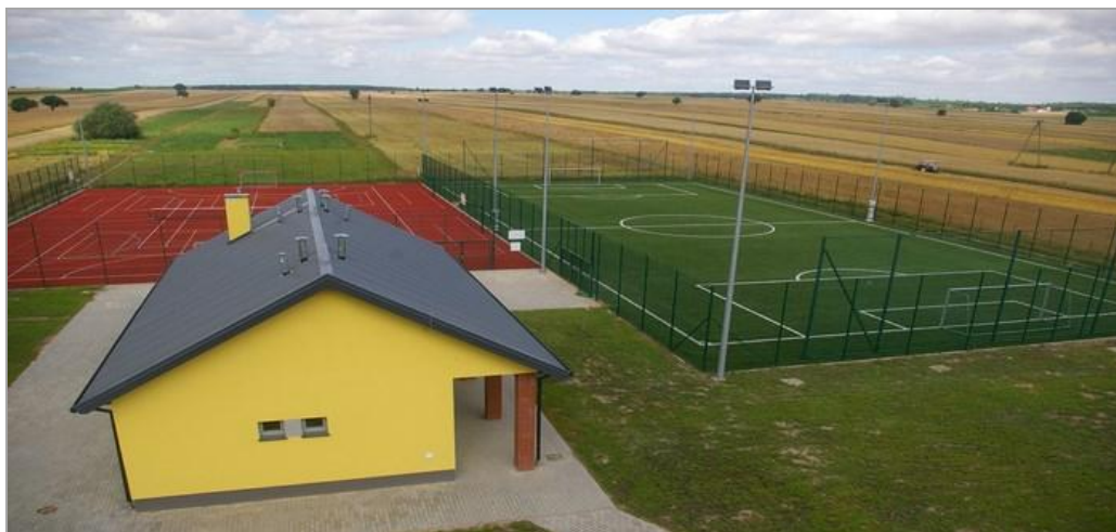
Zdjęcie 8. Kompleks boisk sportowych w Bystrzycy Starej.
