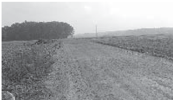
Przebudowa nawierzchni drogi gminnej w Żabiej Woli
