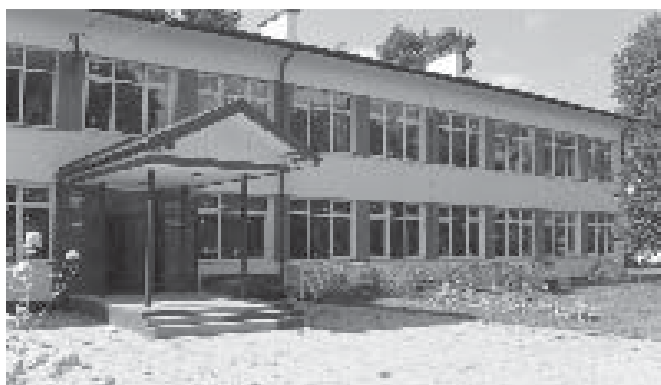
I etap termomodernizacji budynku PSP w Żabiej Woli
