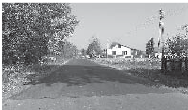
Przebudowa nawierzchni drogi gminnej w Pawłowie
