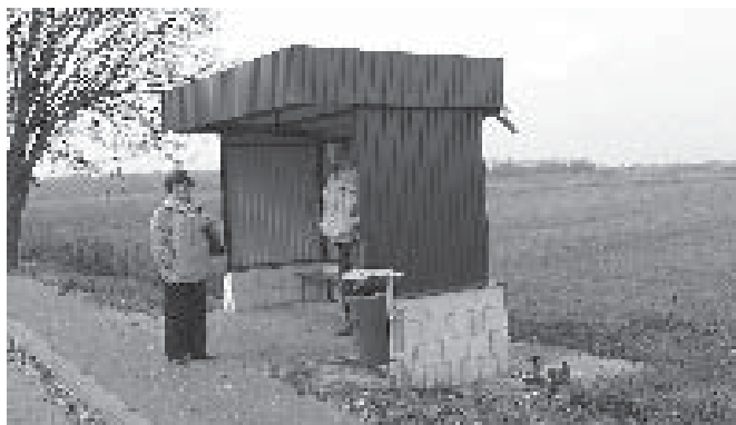
Wykonanie przystanków autobusowych
