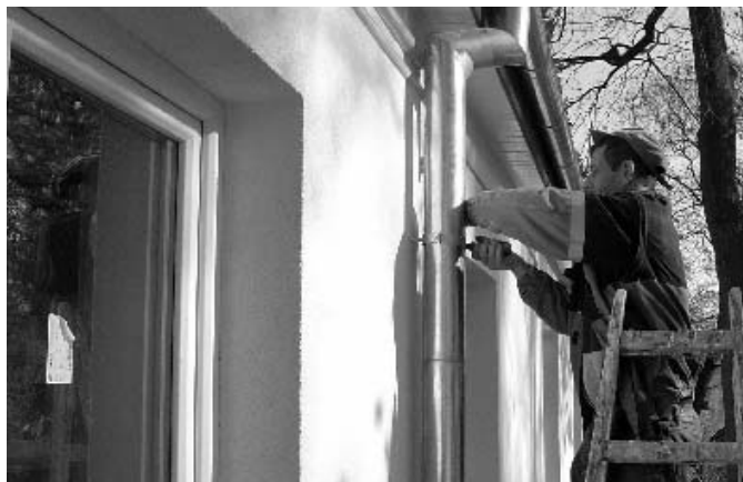
Prace remontowe w budynku Klubu Sportowego POM ISKRA w Piotrowicach
