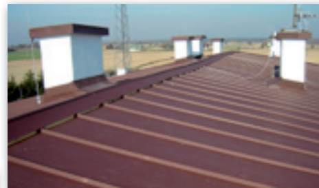
Nowy dach w PSP w Osmolicach Pierwszych.
