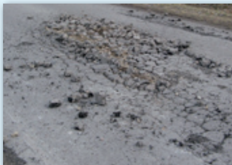
Tak wyglądają drogi zniszczone przez przeciążone samochody ciężarowe.
