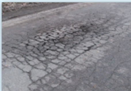
Tak wyglądają drogi zniszczone przez przeciążone samochody ciężarowe.
