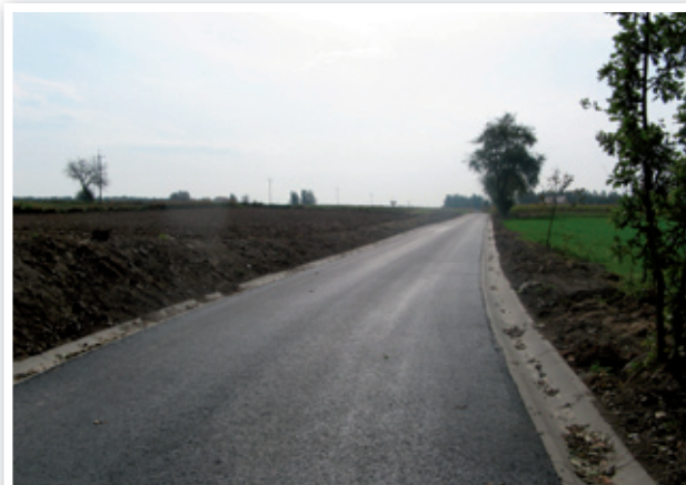
Nowy odcinek drogi powiatowej w Piotrowicach
