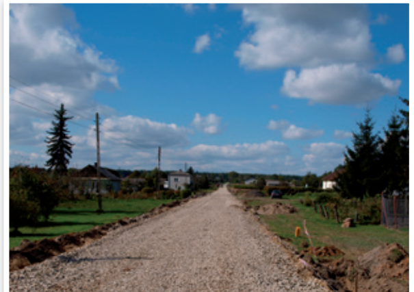
W pierwszej połowie października zakończą się prace przy budowie drogi gminnej w Osmolicach Pierwszych
