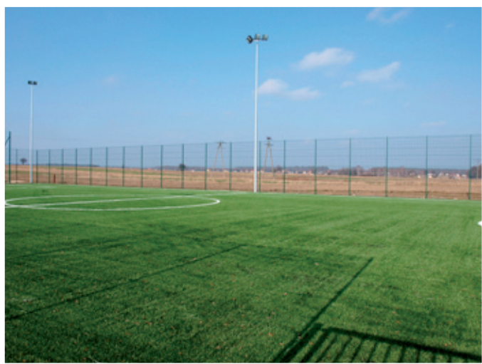
Fot Arch. UG Strzyżewice
