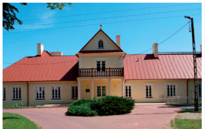
Fot Arch. UG Strzyżewice
