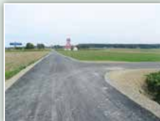
Przebudowa drogi gminnej nr 112511L w Kielczewicach Górnych
