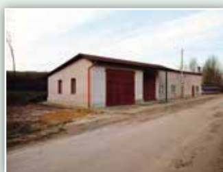
Remiza OSP Franciszków od strony drogi powiatowej
