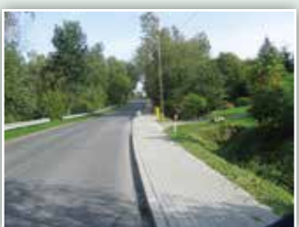
Chodnik przy drodze powiatowej w Kielczewicach Górnych
