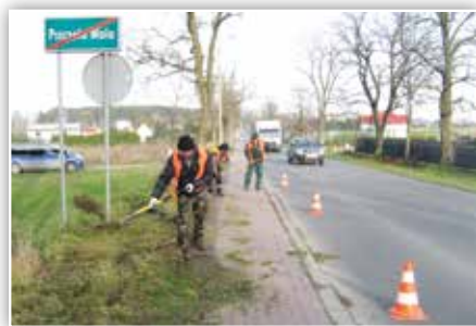
Prace porządkowe na chodniku
