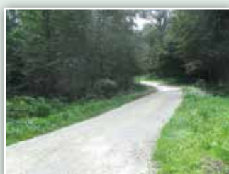
Wyremontowana droga gminna nr 107145L w Borkowiznie
