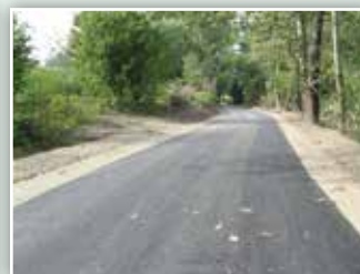
Przebudowa drogi gminnej nr 112523L w Kielczewicach Górnych
