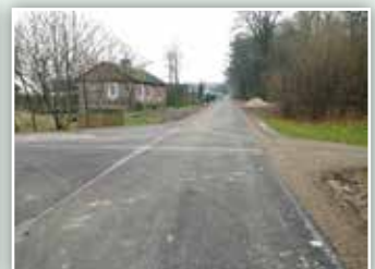
Droga nr 112484L w Osmolicach Drugich
