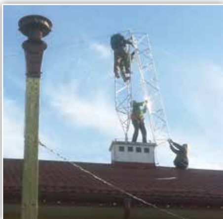
Stawianie masztu na budynku Urzędu Gminy w Strzyżewicach
