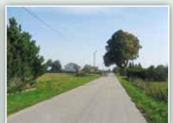
Oświetlenie drogi gminnej w Piotrowicach (Kolonia)
