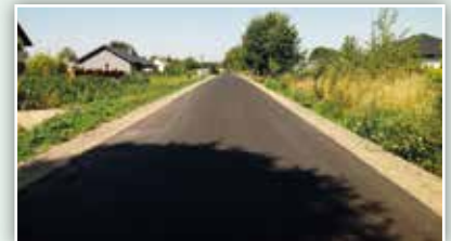
Przebudowana droga gminna nr 107122L w Osmolicach Pierwszych
