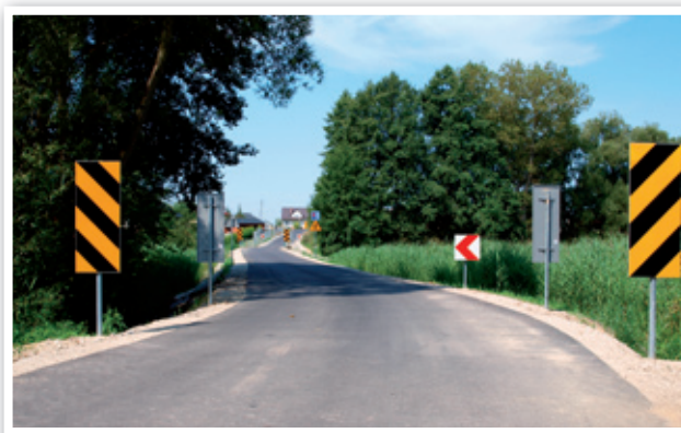
Na utwardzenie drogi w Bystrzycy Starej gmina otrzymała dotację z Ministerstwa Administracji i Cyfryzacji w kwocie 70 000,00zł.
