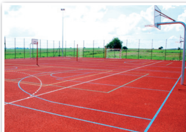
W pierwszej połowie tego roku wykonano boisko o nawierzchni poliuretanowej do gry w piłkę ręczną, koszykówkę, siatkówkę i tenisa ziemnego
