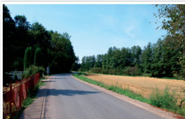
Drogę w Dębinie przebudowano na odcinku 260mb do skrzyżowania z drogą powiatową Strzyżewice - Zakrzówek
