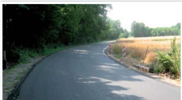
Droga gminna nr 107136L zostanie przebudowana łącznie na czterech odcinkach
