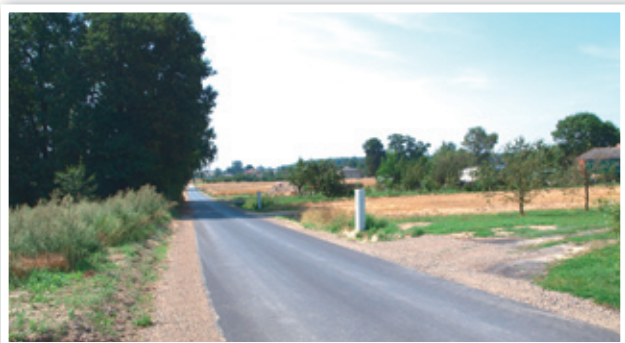
W Kajetanówce przebudowano drogę na odcinku 243mb
