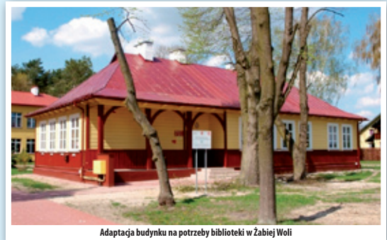
Adaptacja budynku na potrzeby biblioteki w Żabiej Woli
