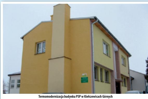
Termomodernizacja budynku PSP w Kielczewicach Górnych
