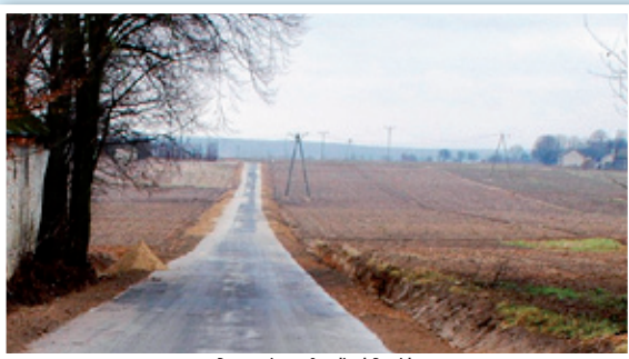
Droga gminna w Osmolicach Drugich
