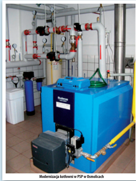
Modernizacja kotłowni w PSP w Osmolicach
