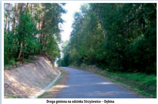
Droga gminna na odcinku Strzyżewice – Dębina
