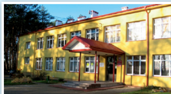
II etap termomodernizacji PSP w Żabiej Woli
