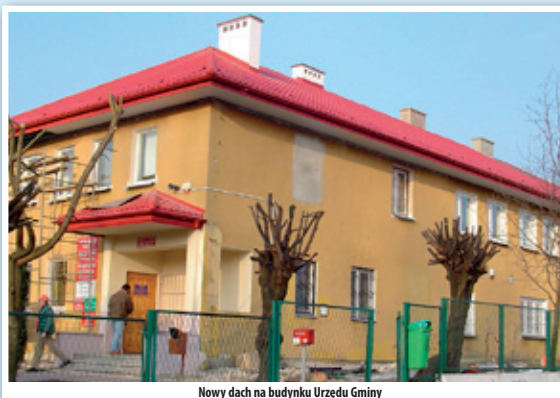
Nowy dach na budynku Urzędu Gminy
