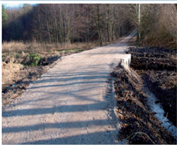
Remont przepustu w Bystrzycy Starej wraz z remontem drogi do Pawłówka
