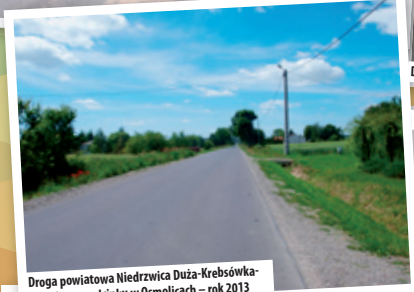
Droga powiatowa Niedzwica Duża-Krebsówka-Osmolice na odcinku w Osmolicach – rok 2013
