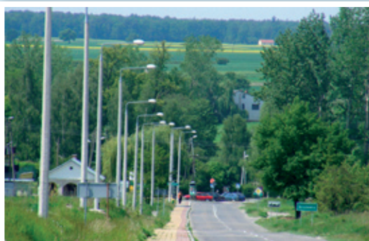
II etap budowy chodnika przy drodze wojewódzkiej w Strzyżewicach
