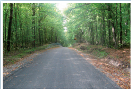
Droga gminna na odcinku Bystrzyca Stara – Piotrowice
