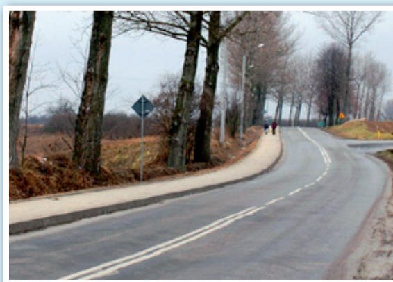
I etap budowy chodnika przy drodze wojewódzkiej w Strzyżewicach
