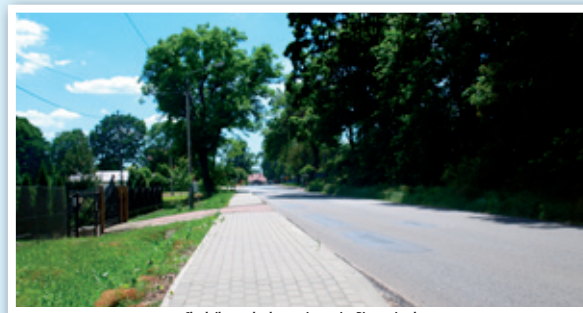
Chodnik przy drodze powiatowej w Piotrowicach
