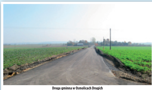
Droga gminna w Osmolicach Drugich
