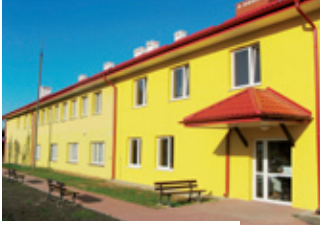
Rozbudowa budynku Urzędu Gminy – rok 2011
