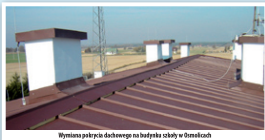
Wymiana pokrycia dachowego na budynku szkoły w Osmolicach
