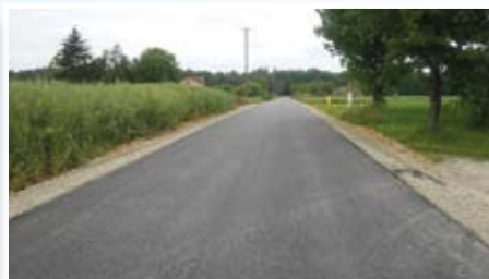
Droga nr 107131L w Bystrzycy Nowej.
