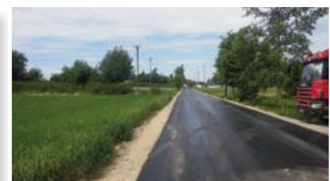
Prace na drodze nr 107122L w Osmolicach Pierwszych.
