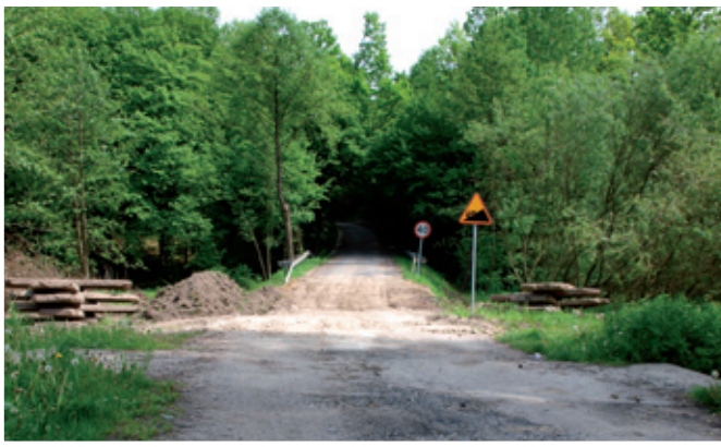
Fot. Arch. UG Strzyżewice
