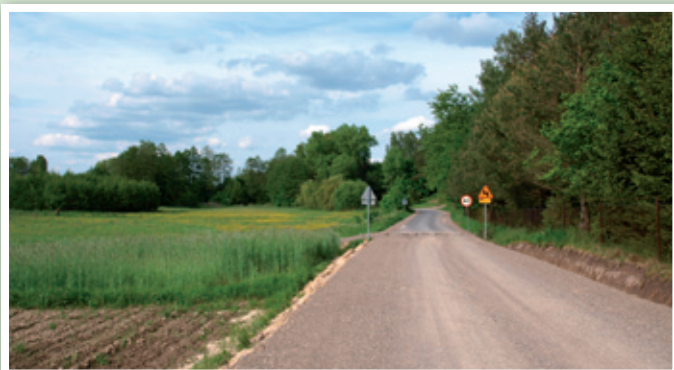
Droga gminna w Dębinie zostanie przebudowana na odcinku 260mb.
