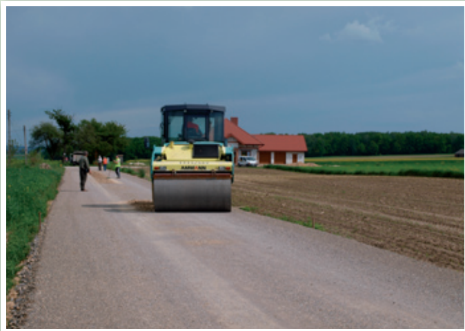
Trwają prace związane z modernizacją drogi gminnej w Kielczewicach Górnych
