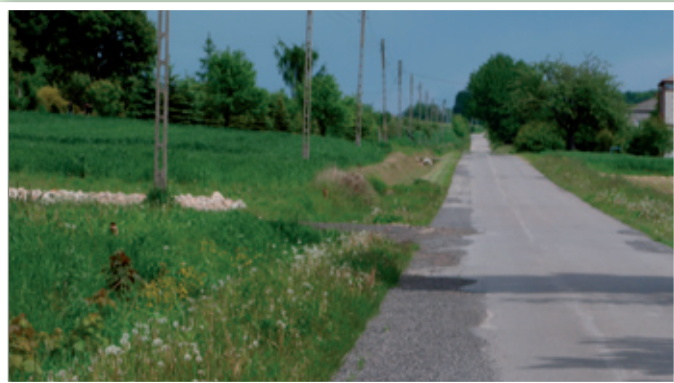
Remonty cząstkowe nawierzchni wykonane zostały m.in. w Kielczewicach Górnych
