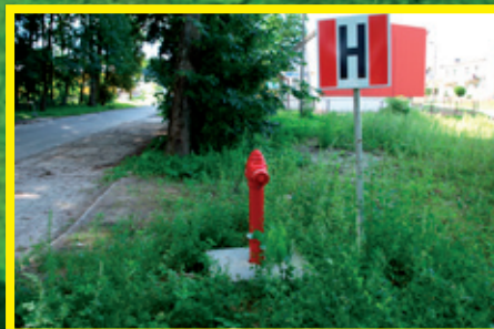
Wodociąg w Piotrowicach
