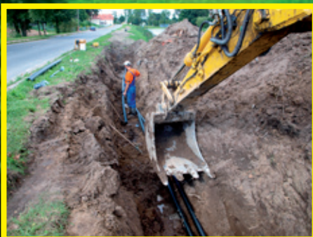
Budowa sieci kanalizacyjnej - rok 2010/11
