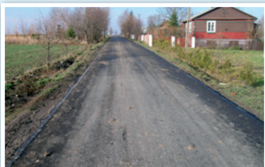
Droga w Kielczewicach Pierwszych – rok 2003
