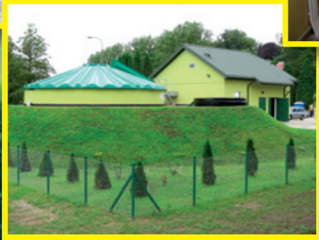
Budynki technologiczne oczyszczalni
