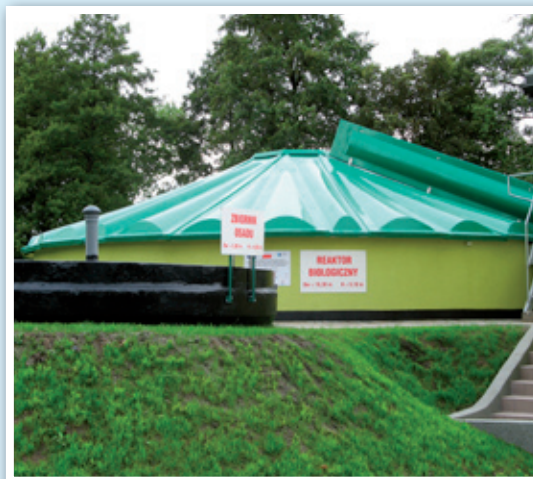
Reaktor biologiczny oczyszczalni ścieków w Piotrowicach
