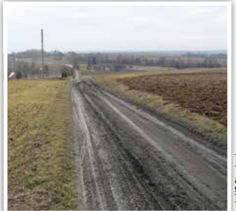
Droga nr 107144L w Kielczewicach Górnych
