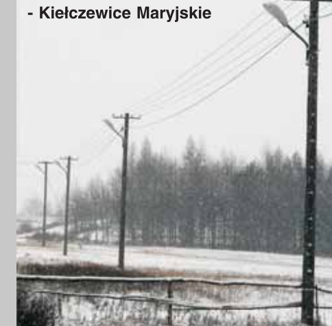
Oświetlenie uliczne - Kielczewice Maryjskie
