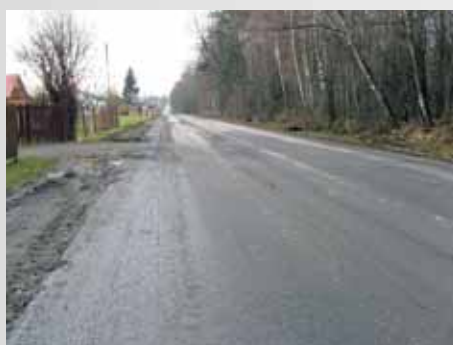
Nowa nawierzchnia drogi w Pawłowie
