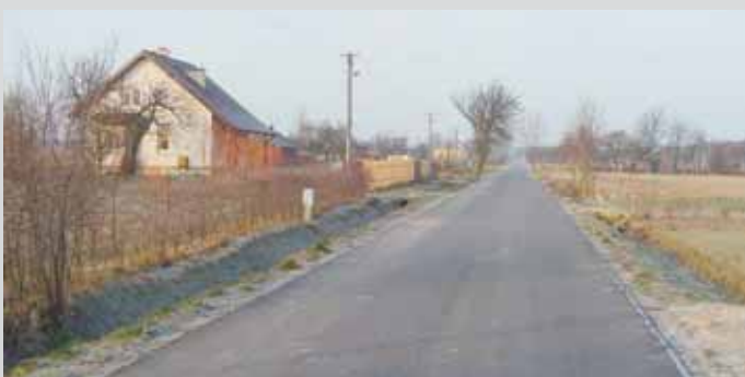
Droga w Piotrowicach Kolonii
