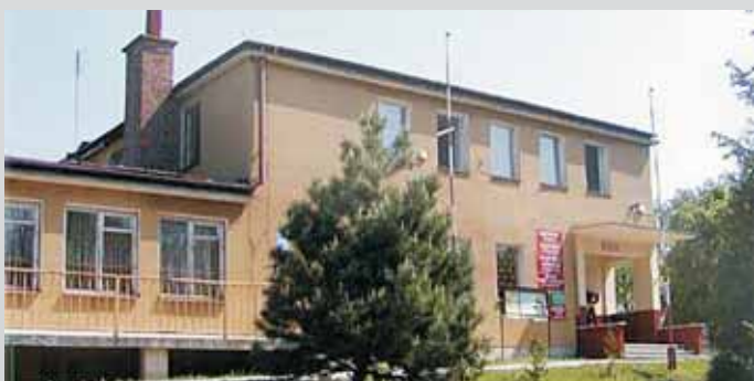
Budynek Urzędu Gminy przed remontem
