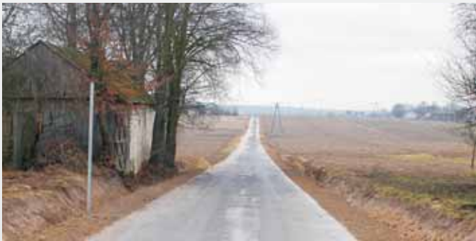
Droga w Osmolicach Drugich
