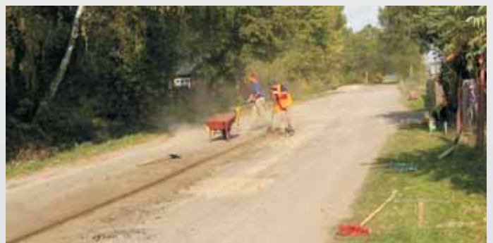
Remont drogi w Pawłowie
