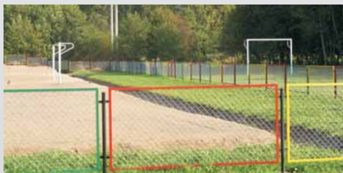
Modernizacja boiska sportowego w Strzyżewicach
