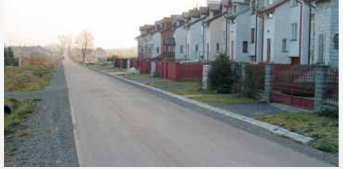
Droga w Żabiej Woli
