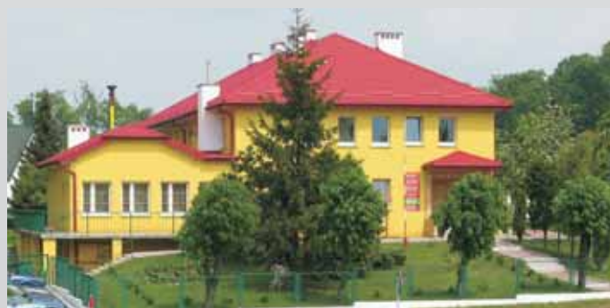
Odnowiony budynek Urzędu Gminy
