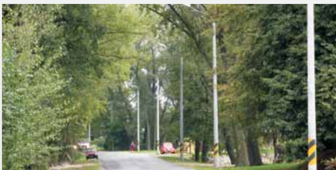
Oświetlenie uliczne w Strzyżewicach
