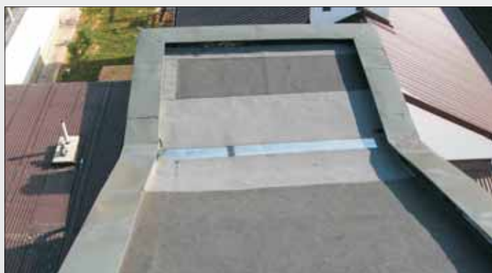
Nowy dach na budynku Zespołu Szkół w Bystrzycy Starej
