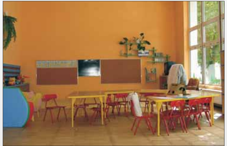
Wyremontowana sala dydaktyczna w budynku Przedszkola w Piotrowicach
