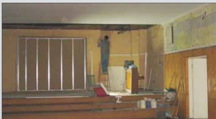
Nowy sufit i przebudowa sceny w sali kinowej CKiP w Piotrowicach
