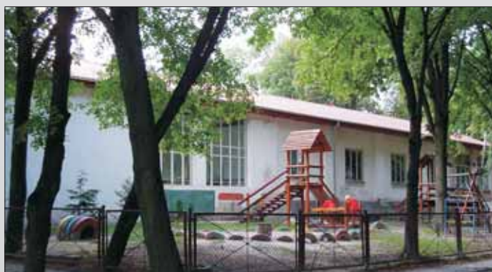
Nowy dach - CKiP w Piotrowicach
