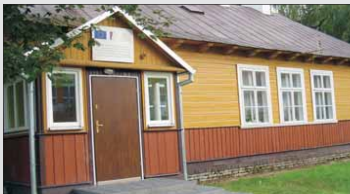
Wyremontowany budynek przeznaczony na świetlicę - SP Żabia Wola
