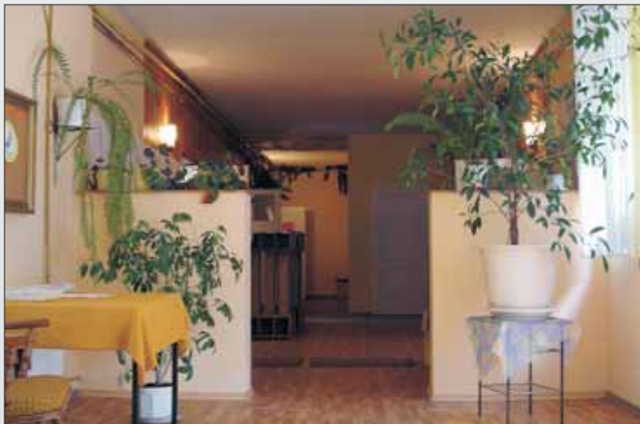
Przebudowa i remont wnętrza budynku Przedszkola w Piotrowicach
