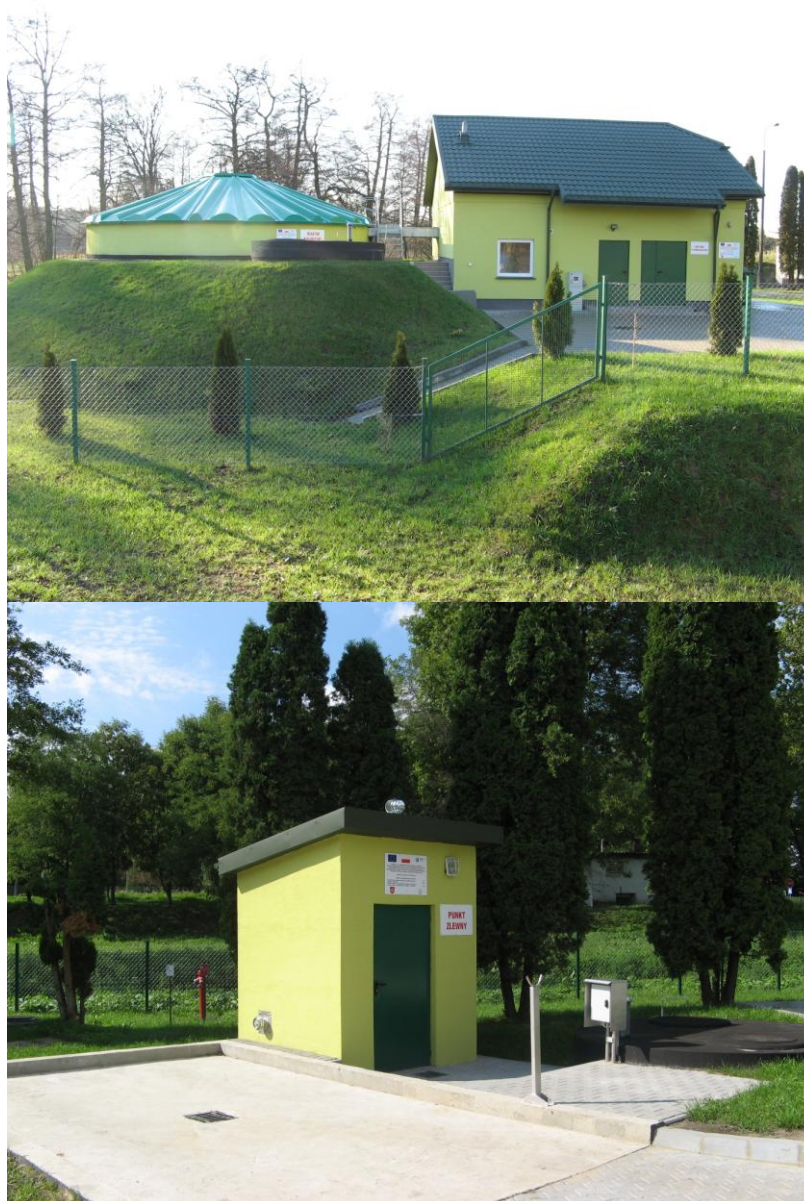
Fot. Oczyszczalnia ścieków w Piotrowicach.
