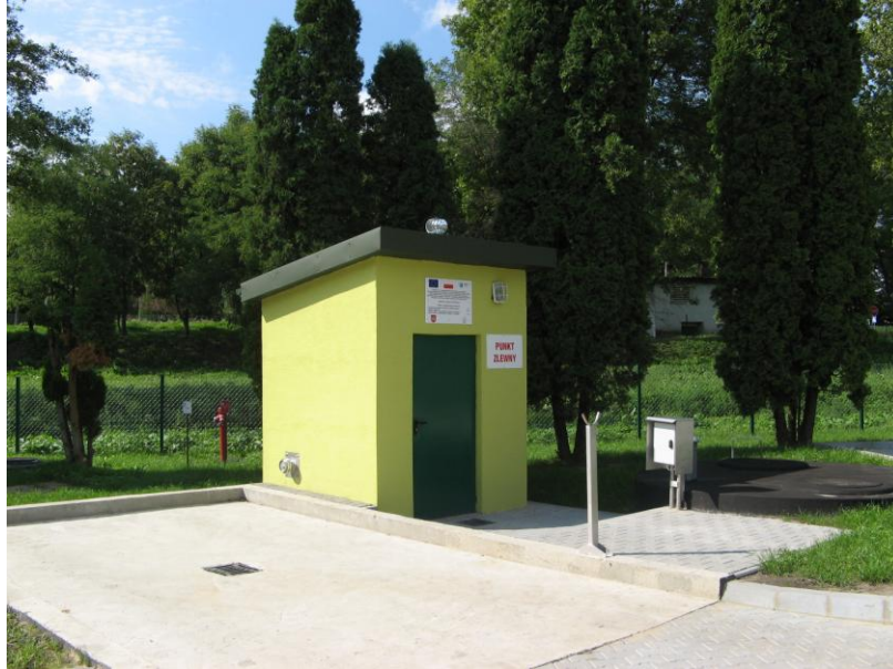
Fot. Oczyszczalnia ścieków w Piotrowicach.
