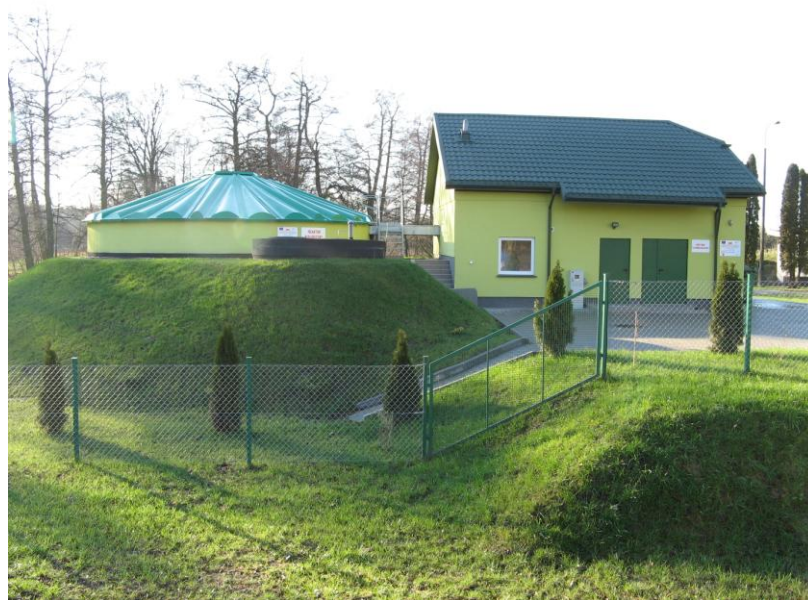
Fot. Oczyszczalnia ścieków w Piotrowicach.
