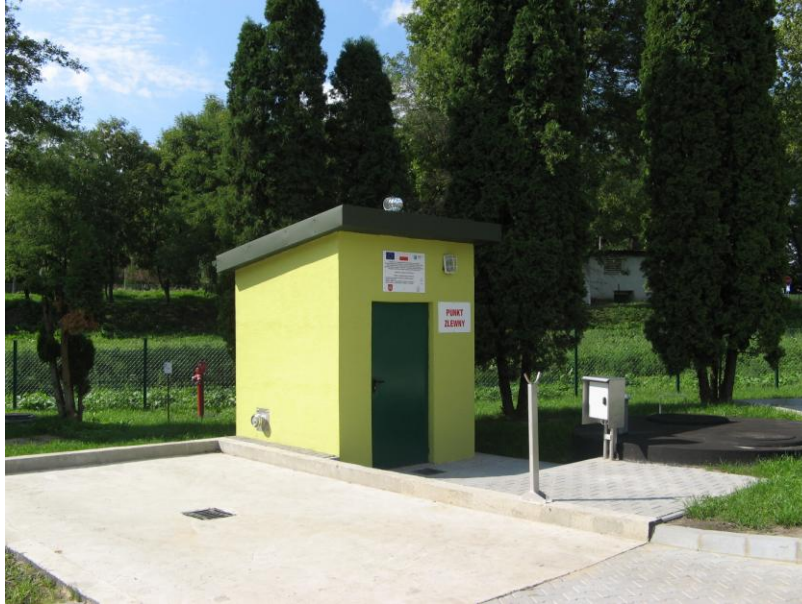
Fot. Oczyszczalnia ścieków w Piotrowicach.
