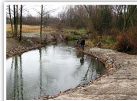
Naprawiona skarpa koryta rzeki w Strzyżewicach
